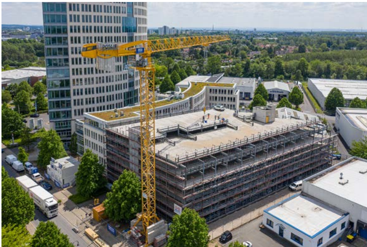
Die Karrié-Gruppe hat mit der Sanierung der Tiefgarage am ABC-Tower begonnen. Foto: Karrié
